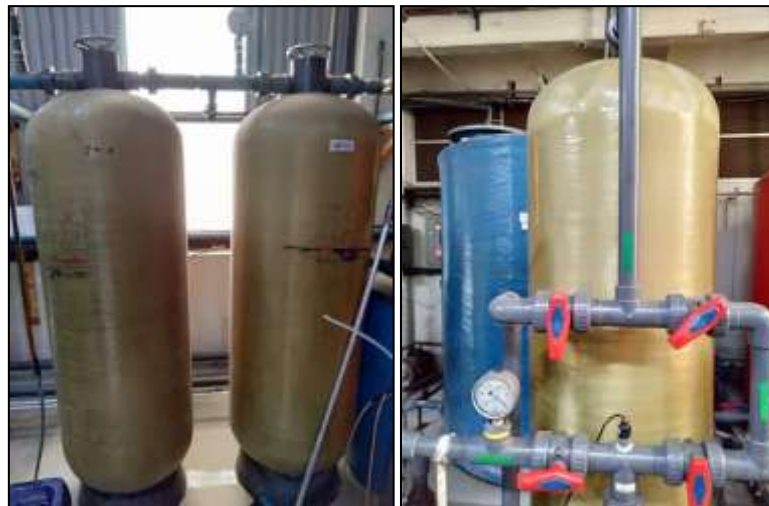
Gambar 1 Tangki Resin Anion dan Tangki Resin Kation di Industri Farmasi PT XYZ
